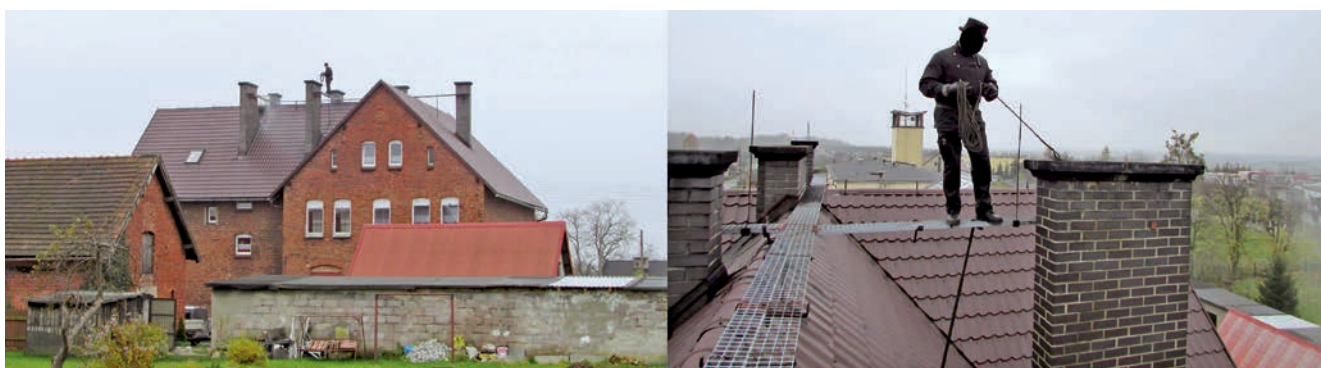
Fot. 4. Kominiarz stojący na podęciu podczas czyszczenia kominu w domu wielorodzinnym; z lewej – widok z poziomu gleby, po prawej – widok z wjazdu dachowego
