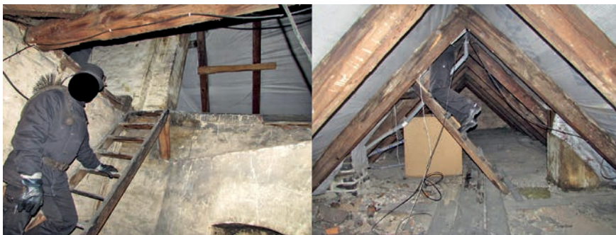
Fot. 2. Droga na dach poprzez strych z wyjściem przez właz
