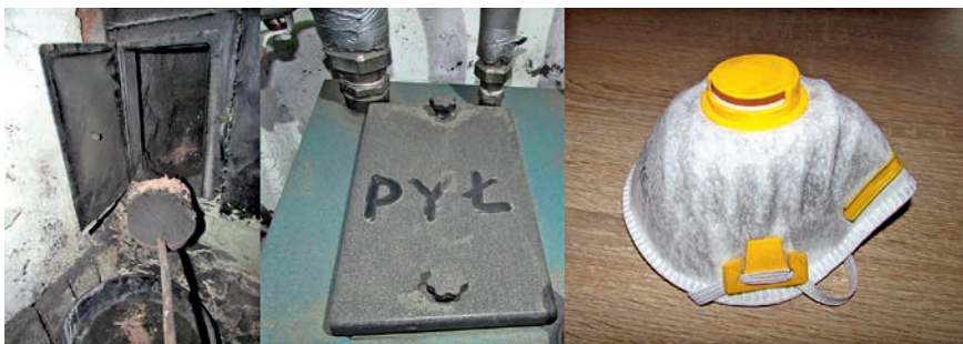
Fot. 1. Opróżnianie wyczystki po czyszczeniu kominu jest równoznaczne z zapyleniem w kotłowni, ukazana z prawej strony maska przeciwpyłowa – tak wygląda po półgodzinnej pracy
