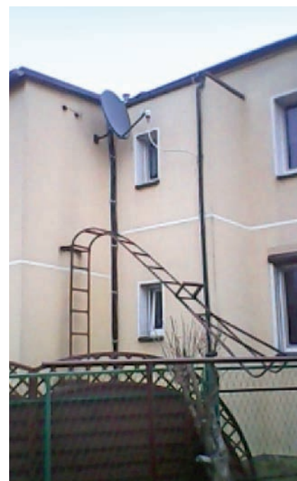
Fot. 3. Wygląd drabiny po wypadku; widoczne jest bardzo mocne odkształcenie w okolicy środka
